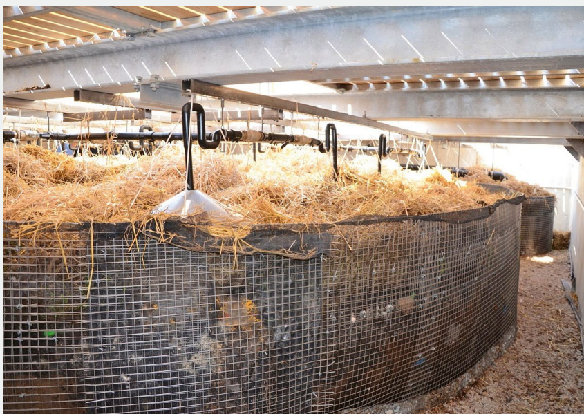
Fig. 2 Wurmkompostierung Coopérative Equilibre in Genf. Dort wandeln Würmer die getrennten Fäkalien zu kohlenstoffreichem organischem Material um, das der Bodenregeneration dienlich ist.
