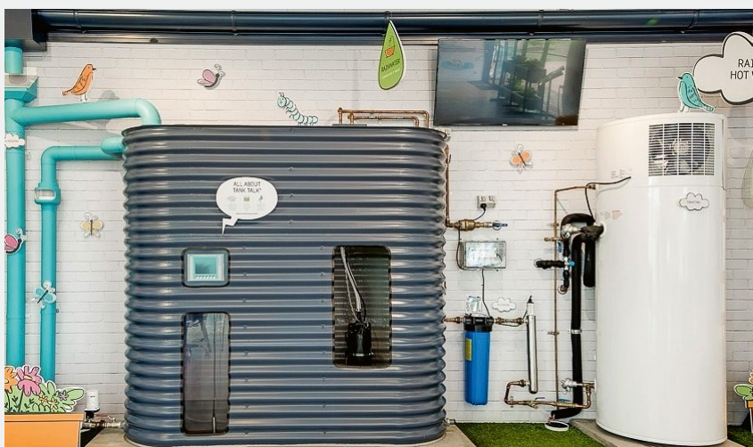
Fig. 6 Die Siedlung Aquarevo am Aussenrand Melbournes hat sich der Nachhaltigkeit verschrieben: Indem es drei Wasserarten in der Siedlung werden, Trinkwasser, rezykliertes Wasser und Regenwasser, können – verglichen mit einer anderen Siedlung der gleichen Grösse – 70% Trinkwasser eingespart werden. (© SEW)
