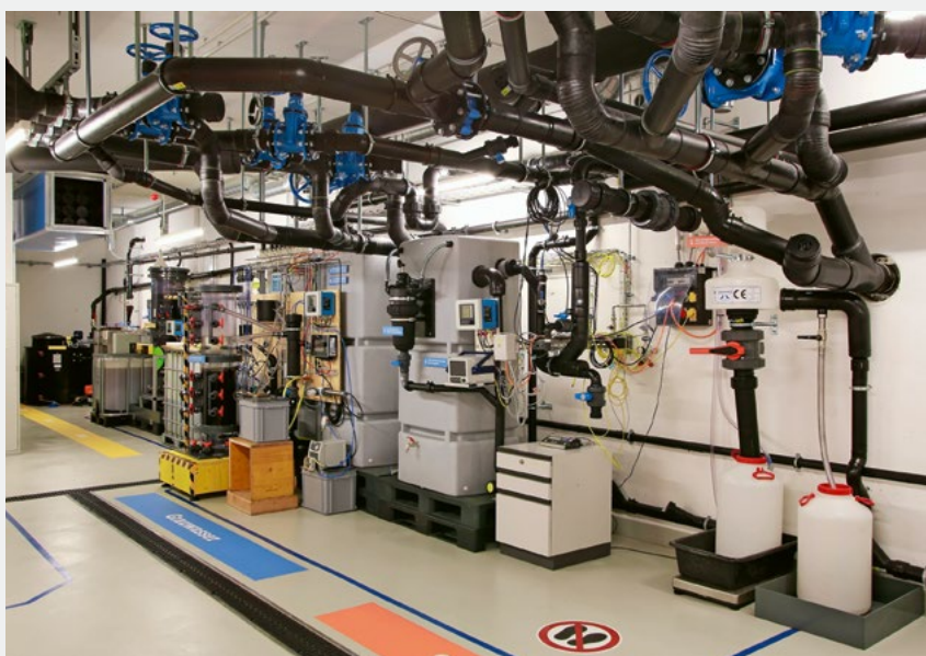
Fig. 4 Water Hub ist ein Teil von NEST. Dort testet die Eawag Systeme, die Wasser und Abwasser möglichst effizient und vielseitig nutzen. (© A. Todaro, Eawag)
