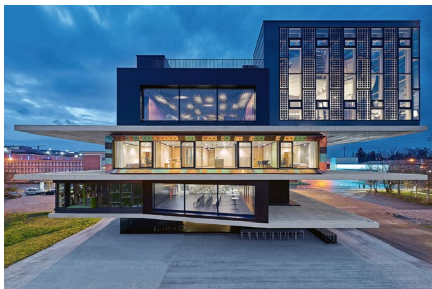
Fig. 2 Im NEST, dem modularen Forschungs- und Innovationsgebäude der Empa und der Eawag, werden neue Technologien, Materialien und Systeme unter realen Bedingungen getestet, erforscht, weiterentwickelt und validiert. Im Keller des Gebäudes befindet sich der Water Hub für die ressourcenorientierte, dezentrale Abwasserbehandlung. (© Zoëy Braun)
